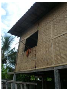
รูปที่ 2.35 ผนังไม้ไผ่สาน (ที่มา: ณัชวิชญ์, 2557)
