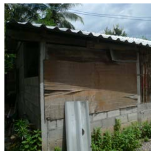
รูปที่ 2.36 ผนังไม้อัด (ที่มา: ณัชวิชญ์, 2557)
